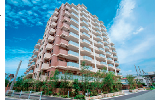
（グランフォーレ大橋東 69戸 平成26年7月完成）
